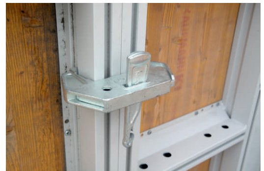
Kraftschlüssige Elementverbindung mit dem MST Standardschalschloss
