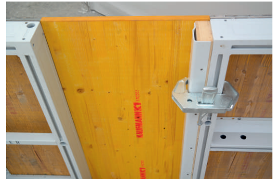
Restmaßausgleich mit Schalhaut-Zuschnitt
