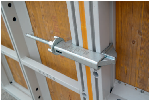
Restmaßausgleich mit Passholz und Schraubzwinge
